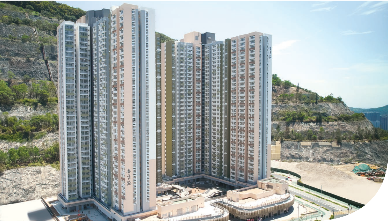
位於安達臣道RS-1公營房屋建造項目落成
